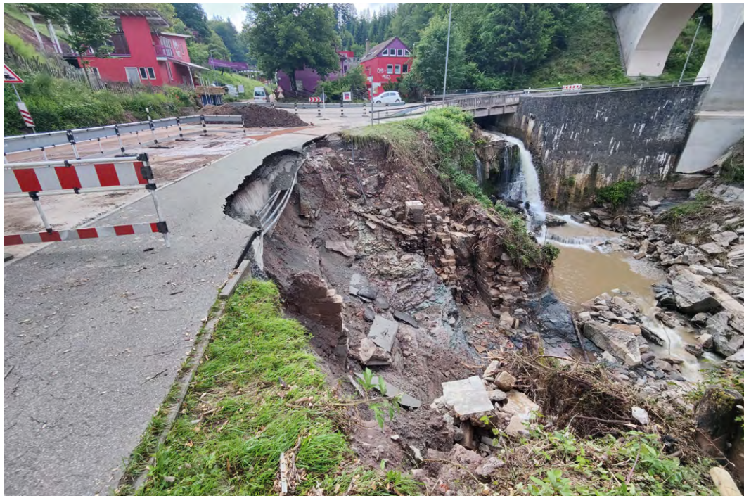
Abbildung 2: Rems-Murr-Kreis – Rutschung an der L 1080 (Quelle: Straßenbauamt des Rems-Murr-Kreises)
